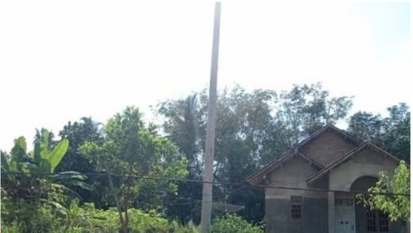
Tiang Listrik di Tanah tak Bertuan
